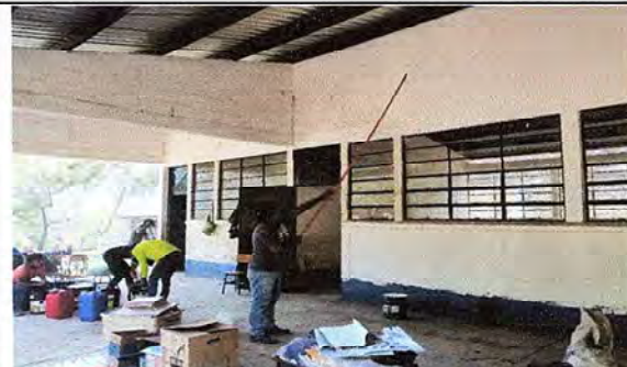
Foto 6: Sustitucion de pintura de aulas.
