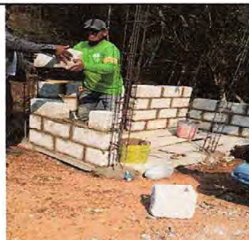
Foto 4: Levantado de Block para dos letrinas
