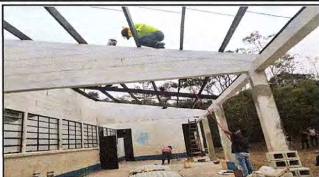
Foto 1: Mantenimiento de costaneras.
